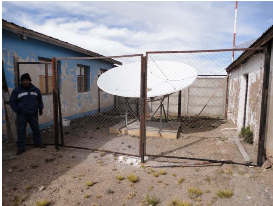
Reparación Cierre localidad de Chislluma.
