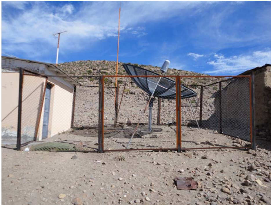
Reparación cierre localidad de Tacora.
